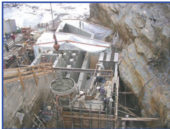
Concrete pour in progress.
